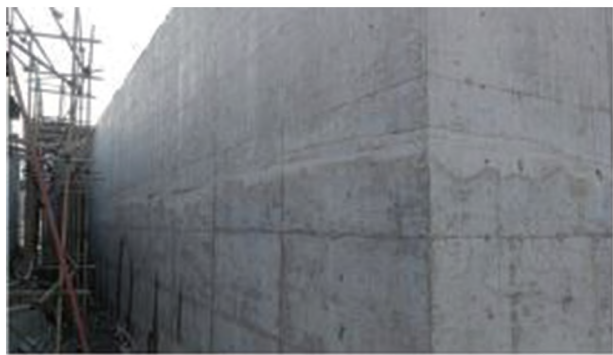
图 2 施工缝实景图
