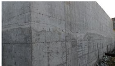
图1 施工缝实景图
